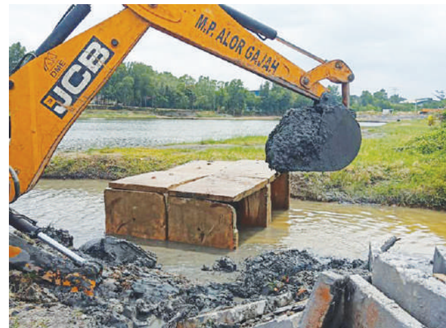
PADA Januari lalu, MPAG melakukan kerja-kerja pemasangan pembentung kekotak di kolam takungan banjir HICOM, Pegoh bagi menaik taraf sistem perparitan, mengelak berlakunya banjir kilat.
