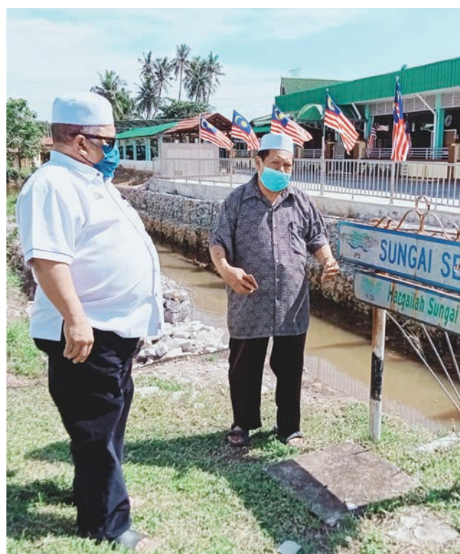
ZAIDI (kiri) bersama Pengerusi Jawatankuasa Pembangunan dan Keselamatan Kampung (JPKK) Serkam Pantai, Othman Saleh (kanan) meninjau jambatan berhampiran Masjid Serkam Pantai yang perlu dinaik taraf bagi menampung limpahan air dari kawasan tinggi perumahan berdekatan.
