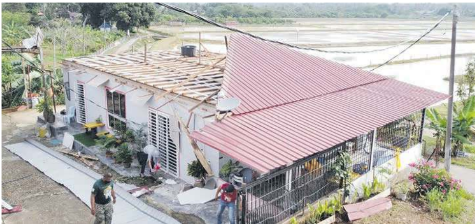
KEROSAKAN pada bumbung akibat kejadian ribut.
