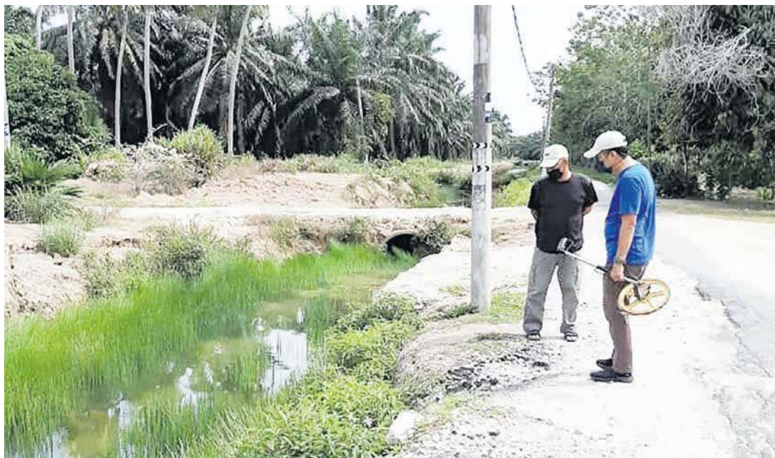
KEADAAN Parit Seman Benteng di Sungai Rambai yang akan dibaik pulih.
