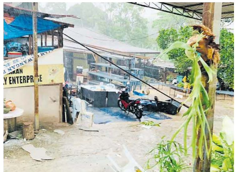
KEADAAN sebuah rumah yang rosak akibat bumbung diterbangkan angin.
