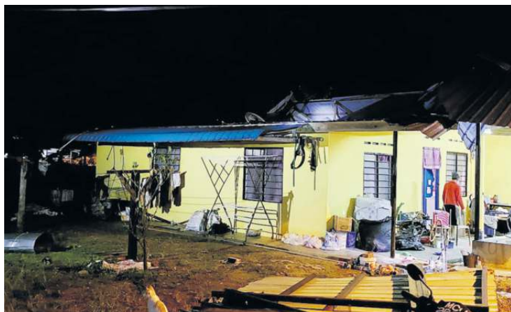
KEADAAN rumah yang dilanda ribut di kampung Belimbing Dalam.
