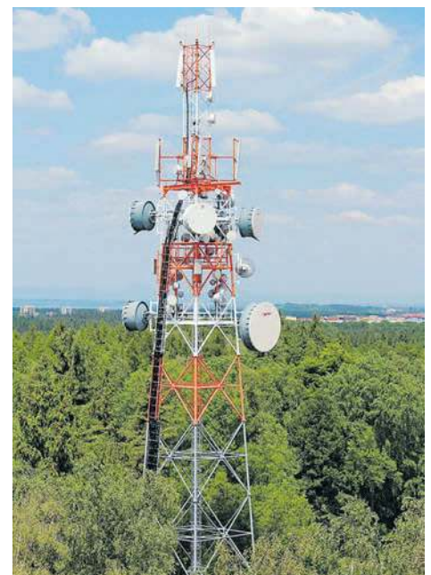
GAMBAR hiasan menara telekomunikasi
