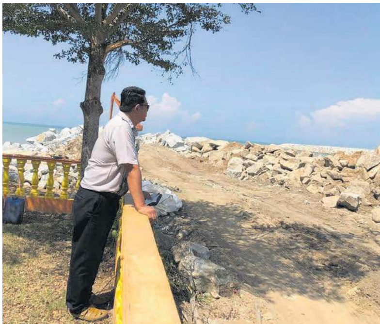
ROSLI ketika meninjau kerja-kerja tambakan batu berhampiran Kompleks Ikan Bakar Terapung Kuala Sungai Baru.
